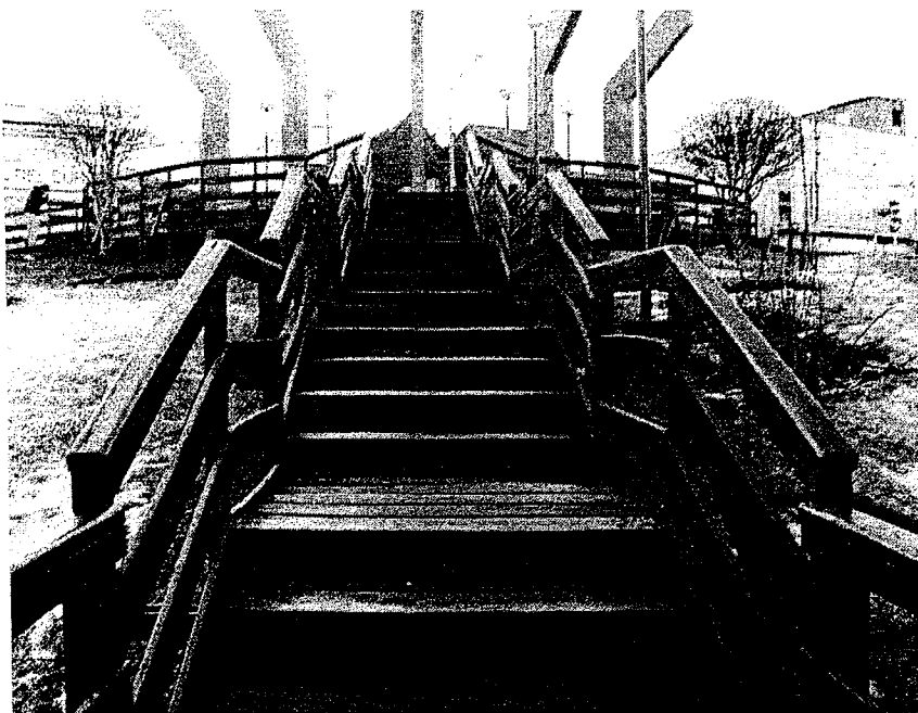
PERDAÑOS CERRADOS CON PEDER Y ALZADA. -
