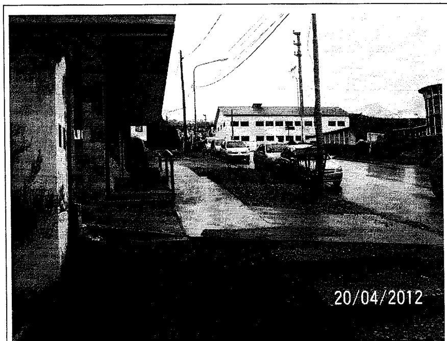
Toma Fotográfica Nº 1: Se observa la delimitación de la vereda y Sector de Apoyo y Equipamiento.
