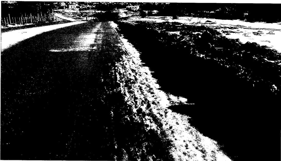
4) Construcción de la calzada de hormigón bajo condiciones meteorológicas altamente desfavorables y fuera de las especificaciones del Pliego de la Obra. Esta circunstancia se traduce en el excesivo desgaste superficial que se observa en la obra y significativa pérdida de la Resistencia del Hormigón de la calzada. Se acompaña documento fotográfico que muestran las falencias mencionadas.
