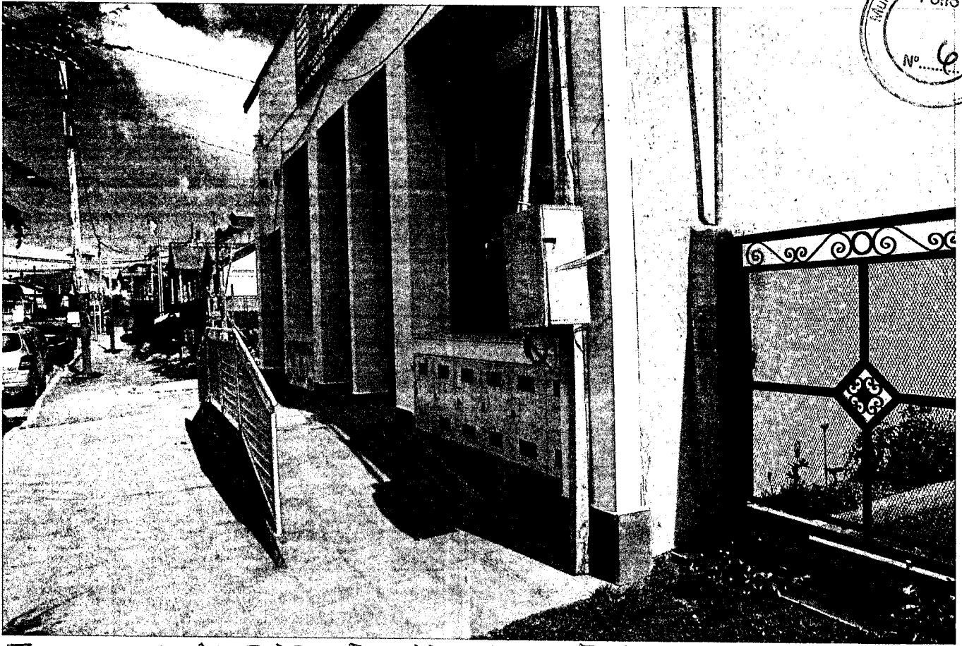
FOTO 1: SE MUESTRA EL DESNIVEL EXISTENTE, LA RAMPA Y VICHOS DE GAS EN LA LINEA MUNICIPAL.
