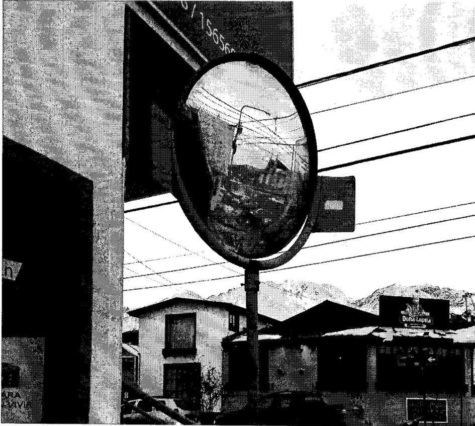
Espejo deteriorado. Se observa un claro desmejoramiento del campo visual, aparente ingreso de agua por agrietamiento en su perímetro.
