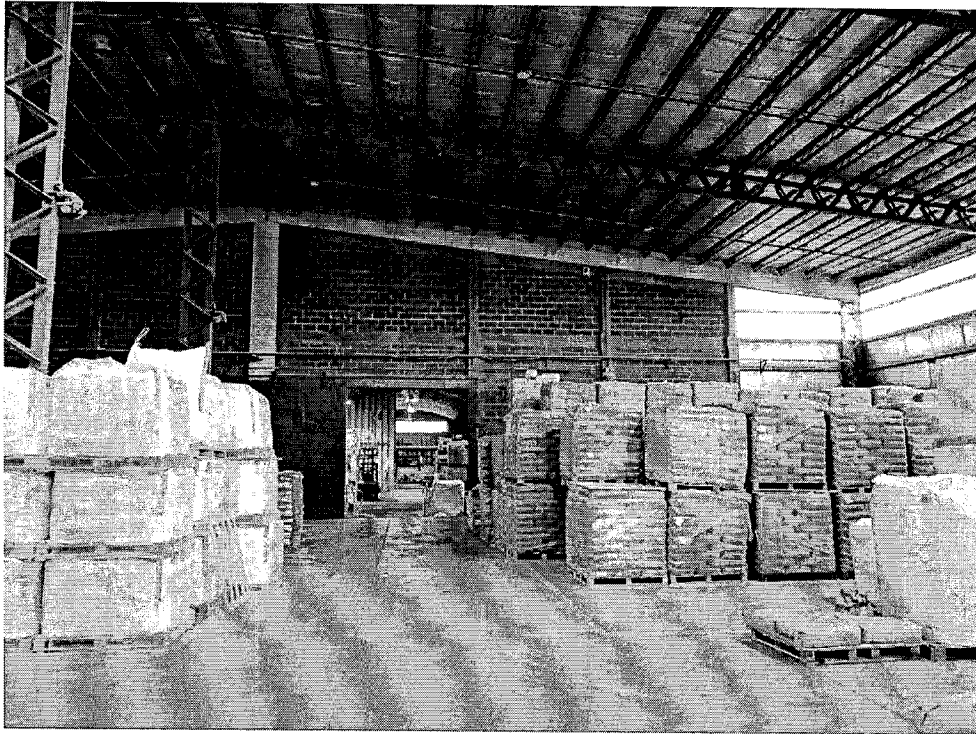
Volumen interior estiba. Obra ejecutada en el año 2012.
