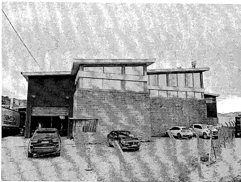
Oficina y depósito obra ejecutada en el año 2012.
