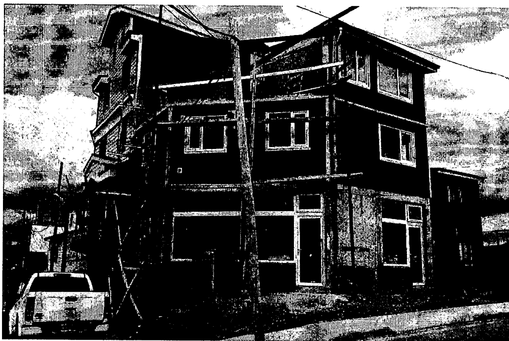
Estado de la obra - Enero 2020
