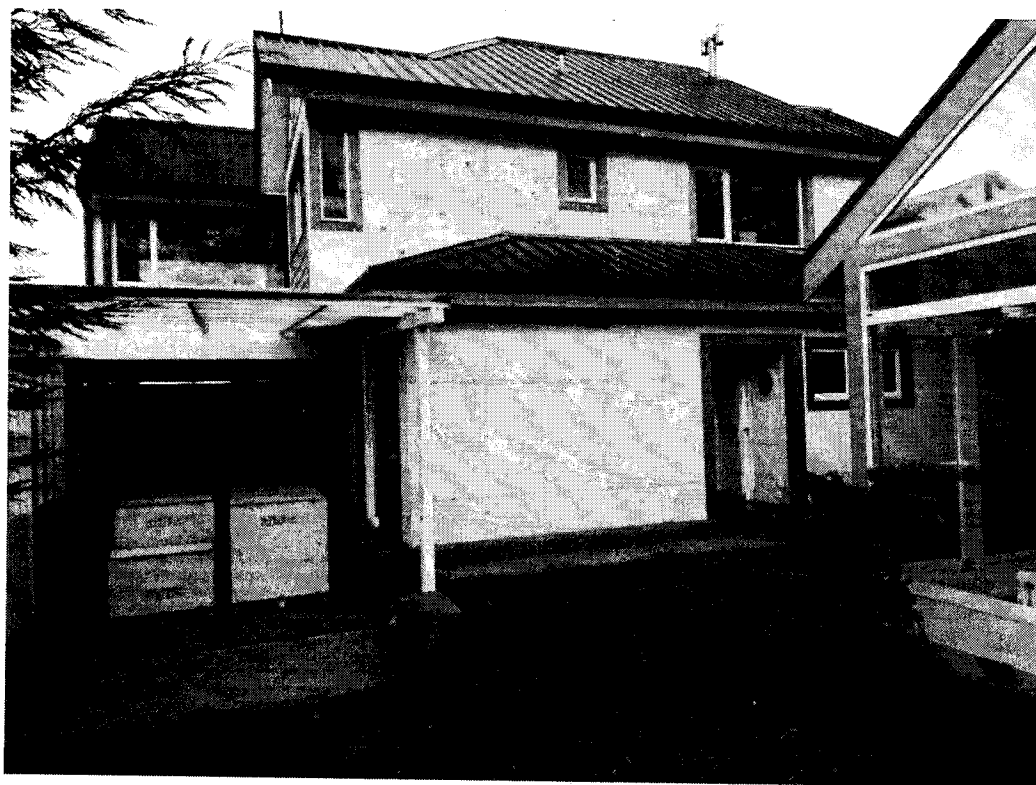
Vista posterior del predio donde se encuentra el ingreso de vehículos y salidas de emergencias del sector de quirófanos.-
