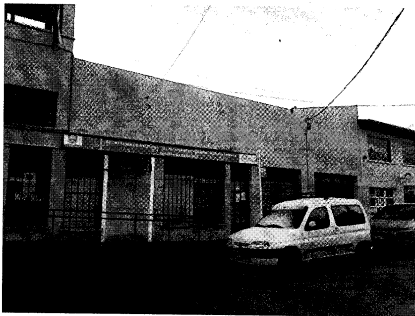
VISTA SOBRE CALLE FIRZ ROY, CONSTRUCCION EN PLANTA BAJA VISADA 07/04/1994
