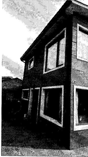
CONTRAFRENTE CASA (ACTUAL)
