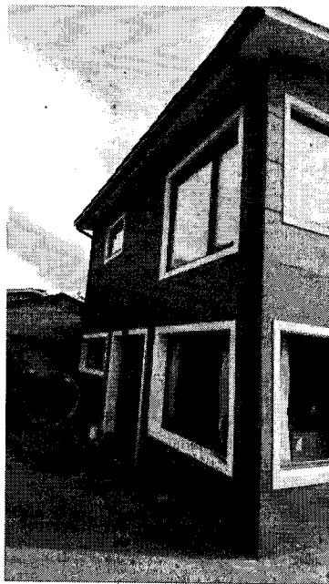
CONTRAFRENTE CASA (ACTUAL)
