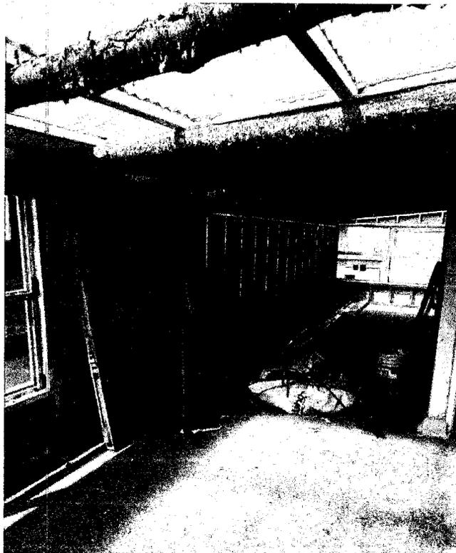
**2- Contrapendiente del Techo:** Sobre la pared mencionada en el punto 1, se ejecutara un contra pendiente del techo, hacia el interior de la construcción, para evitar que las aguas pluviales desagoten sobre el terreno del vecino.
