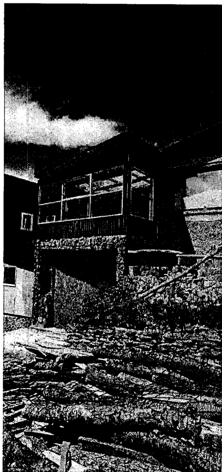
Vista frontal (se resalta los locales que invades retiros)
