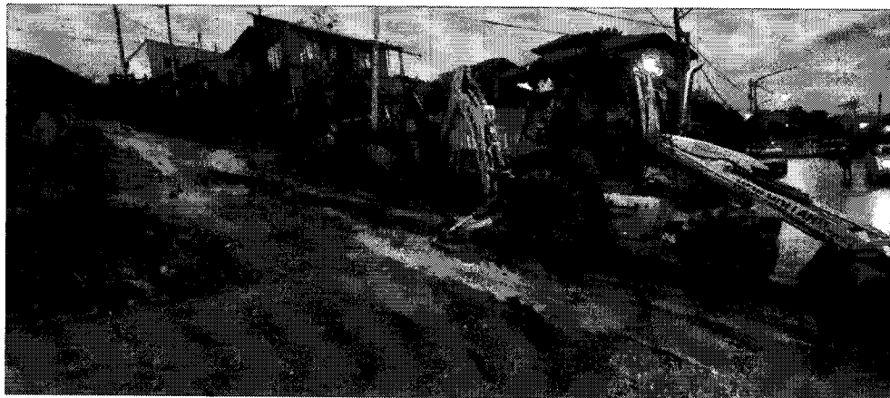
Imagen 3. Movimiento de suelo calle Karukinka Norte, 04/06/2024.
