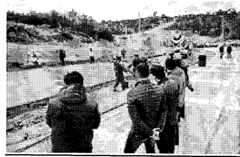
El Intendente Daniel Harrington junto a los concejales Rosana Taberna y Matias Rodriguez, recorrieron el inicio del hormigonado en el segundo tramo sur de la pavimentación de Av. Los Ñires.
