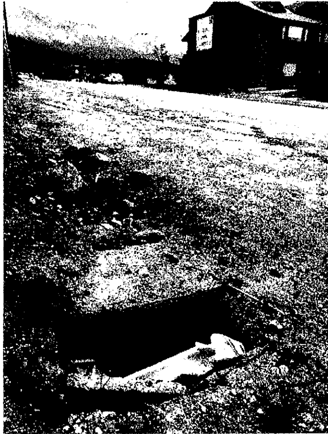
Ⓞ Pozo Sobre Av Los Ñires y Calle del Recodo, repleto de basura, en especial residuos de obra.
